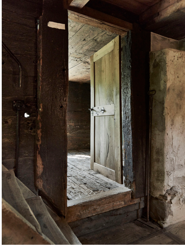
Baudenkmal Haus Tannen, Morschach SZ, 2017
